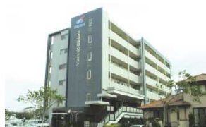
●平成13年1月 タカダ新都心マンション竣工
